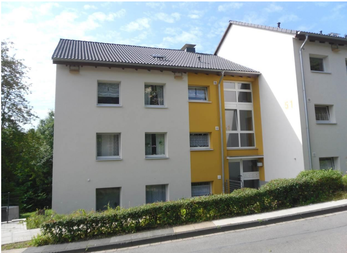
Abb. 2: Gezielte Brutplatzverlagerung mittels künstlicher Nisthilfen neben der Fensterfron
